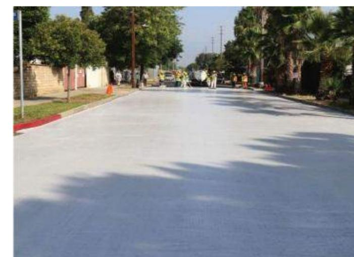
Figura 12: Esempio di pavimentazione in asfalto con rivestimento ad elevato albedo - Los Angeles, California
